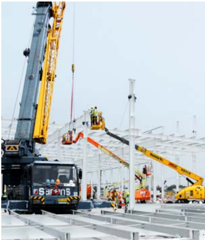
建設工事中揚重設備機器
