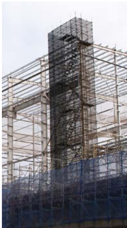
建設工事中の安全はしご
